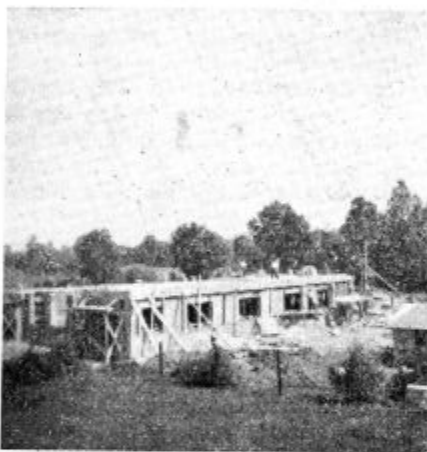
Dela pri gradnji nove postaje v Domžalah. (Slikano v avgustu.)
