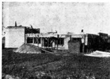
Pogled na novo relejno postajo pri Mariboru. Stavba bo dobila v nekaj dneh streho.
