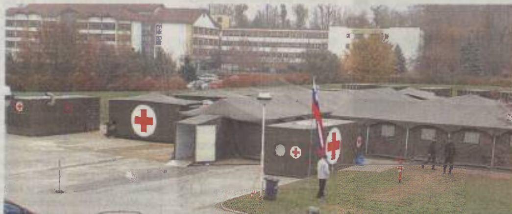
Role 2 sestavlja 18 zabojnikov. Sedem je medicinskih in 11 logističnih. Sistem je modularen, kar pomeni, da ga je možno povečevati. Je samozadosten, saj ima svoje električno napajanje ter zabojnika za zbiranje odpadnih voda in s prečiščeno vodo. Po dokončni uvedbi v operativno uporabo v Slovenski vojski ga bo mogoče uporabljati tudi na mirovnih operacijah v tujini.
