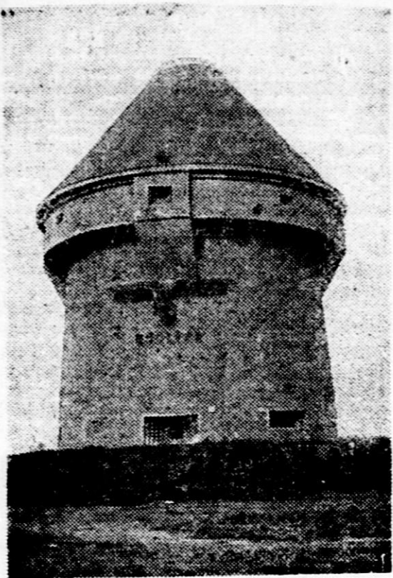
Nemško zaklonišče v obliki oklopnega stolpa
