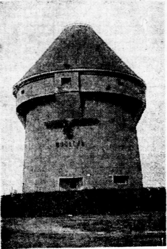
Nemško zaklonišče v obliki okroglega stolpa
