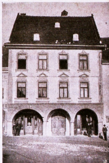
Prenovljeno poslopje. ◦ Renoviertes Gebäude.
