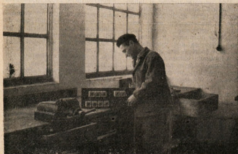
Montaža razdelilne plošče v elektro delavnici naših stranskih obratov
