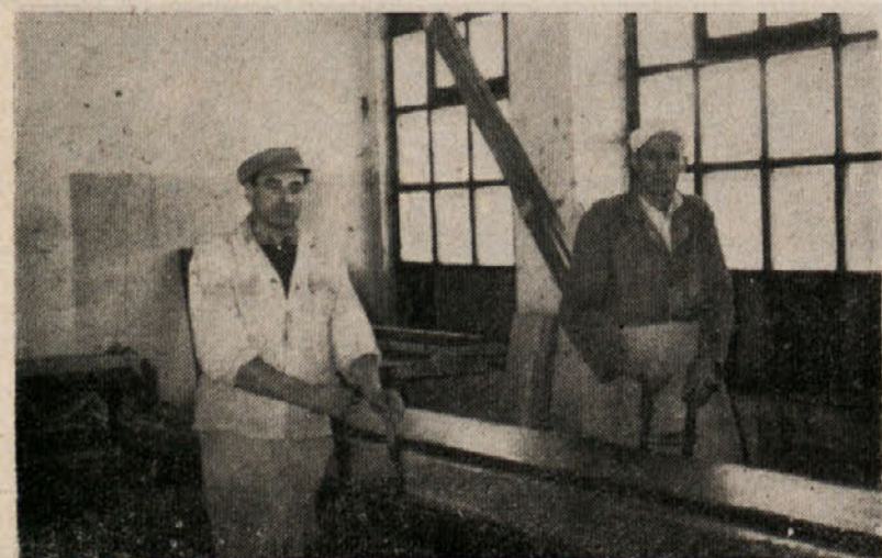
Skupinovodja Mastnak in tov. Križan v obratu »Cementnine« na Lavi ob zabetoniranih montažnih ramenih
