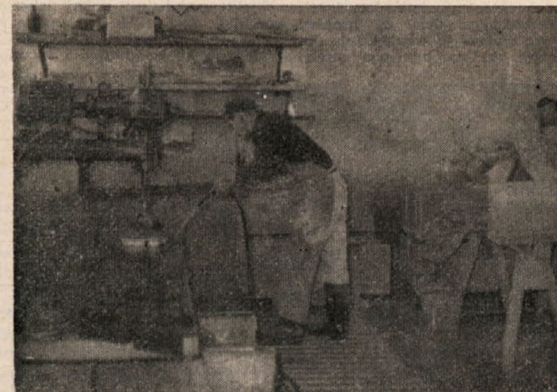
Strojno in ročno brušenje montažnih elementov v obratu »Cementnine na Lavi«
