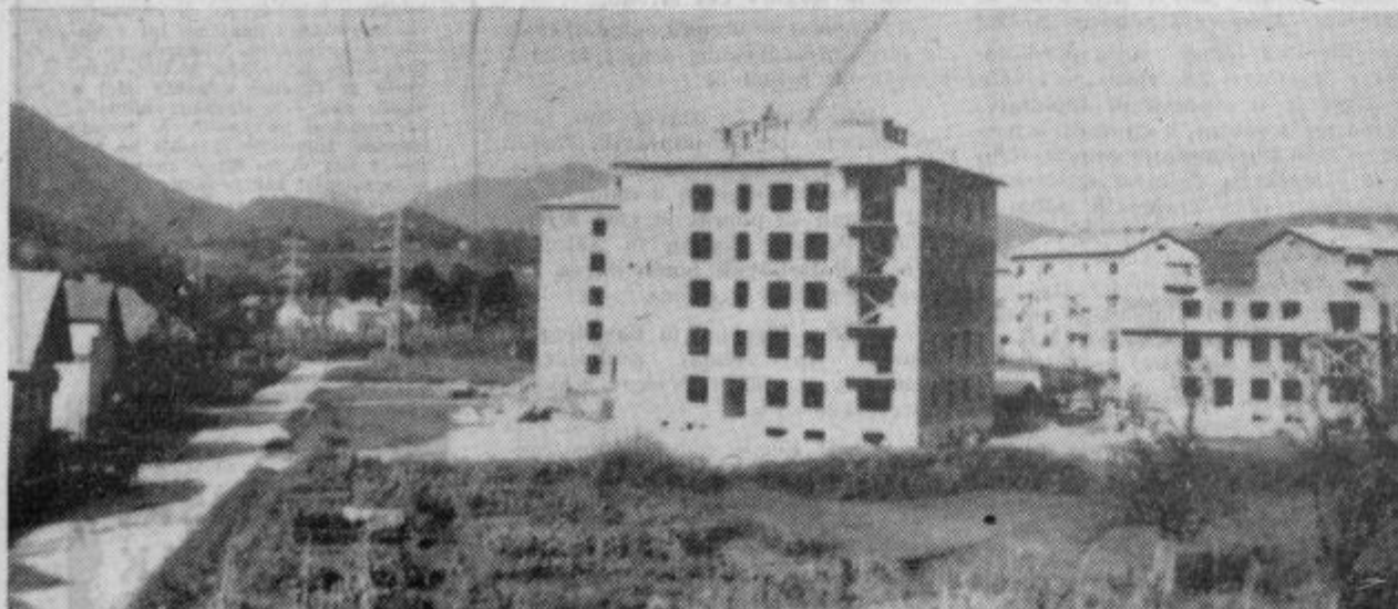
Gradnja stolpičev v naselju Skalce, ki jih gradi celjsko gradbeno podjetje Ingrad bo v naslednjem letu dovršena. Vseh enaindesedemdeset stanovanj so odkupila konjiška podjetja in občinska skupščina. Foto: J. Sever
