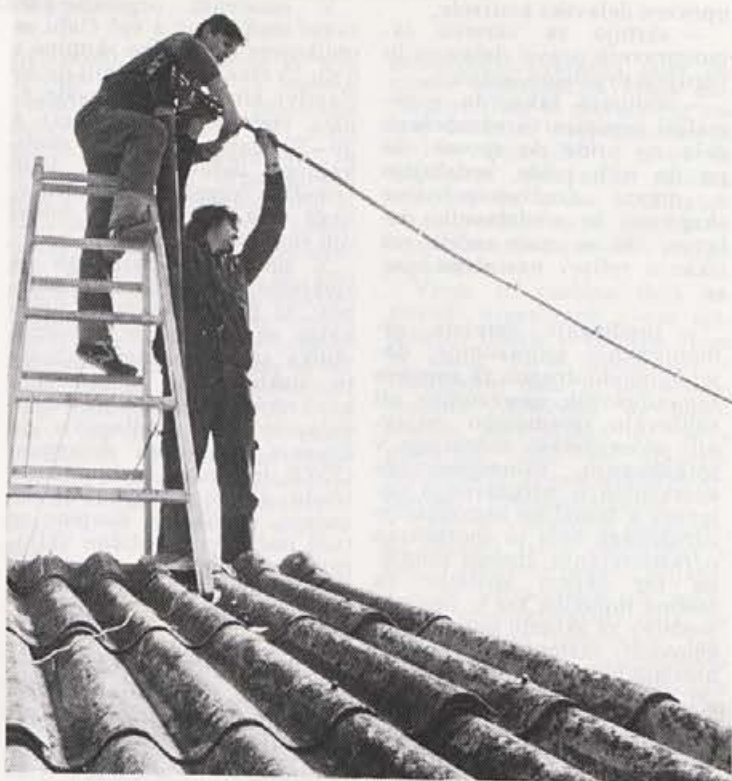
Montaža novega električnega voda za menzo
