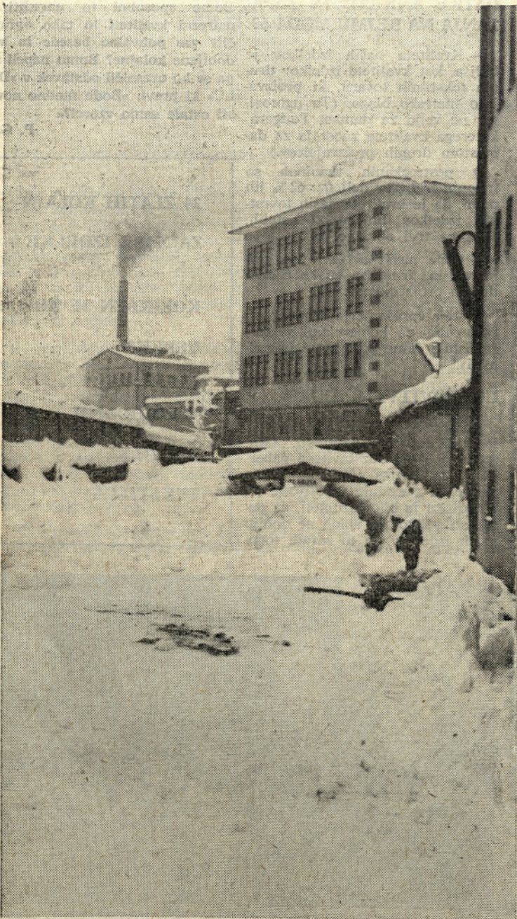
— Pogled na del obrata I. Povsod je sneg. Na kolesarnici ga je bilo preveč, pa je omagala.
