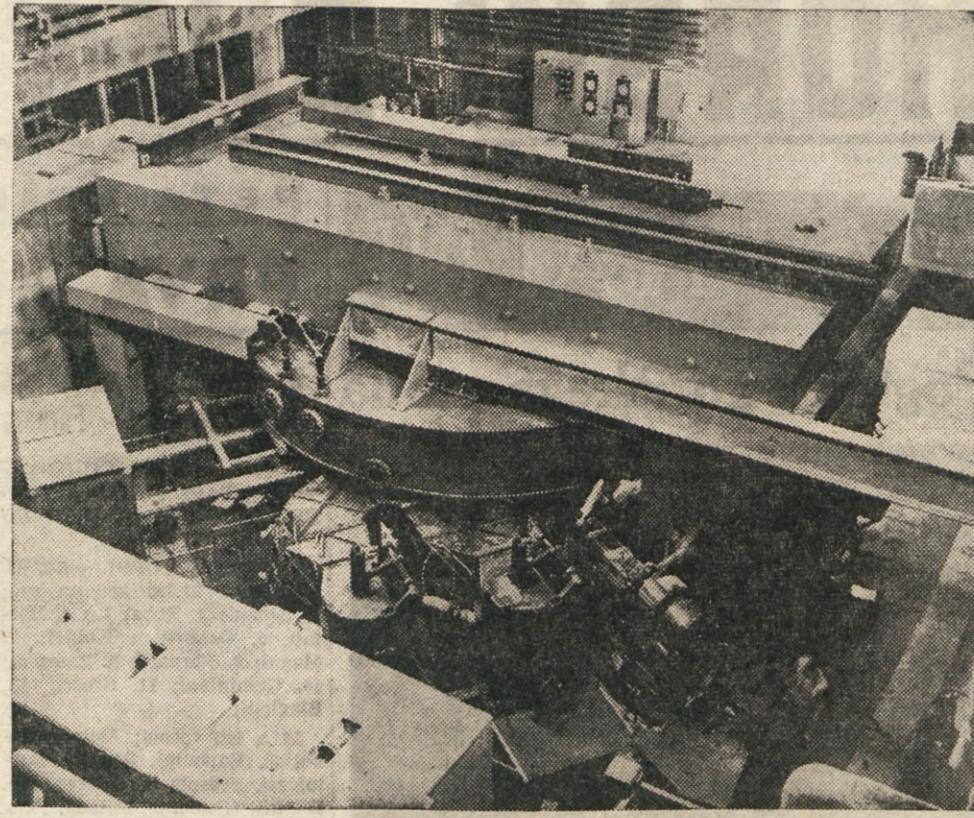
Kemična separacija, ki je del atomskih naprav v Hanfordu. Tu proizvajajo cepljivi pluto- nij. Znanstveniki delajo z mehaničnimi rokami in nadzirajo kemični proces s periskopom iz težkih svinčenih ter betonskih sten, ki jih ščitijo pred smrtonosnim izčiravanjem.
