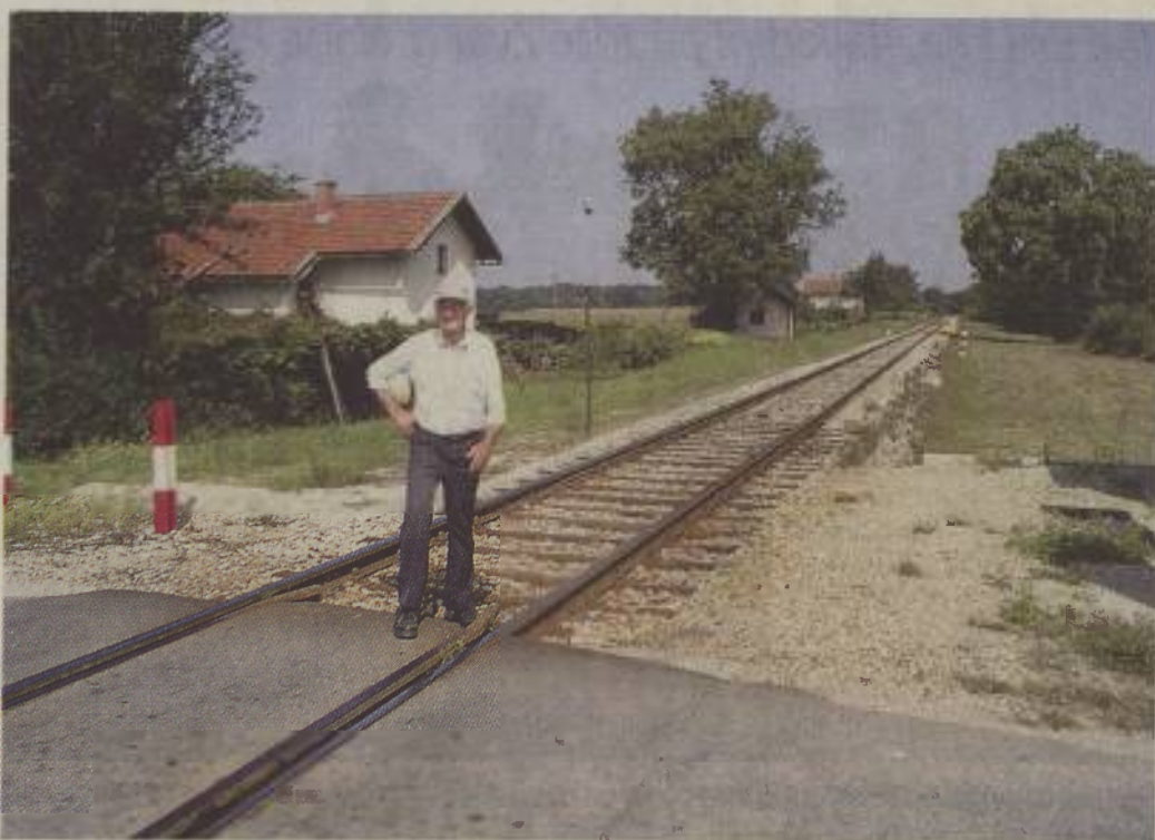
Kjer se nivojsko križata cestni odsek Veržej-Krapje in železniška proga Murska Sobota-Ljutomer (blizu stoji tudi čuvajnica oz. Srševovo stanovanje), se je zgodilo že več nesreč s smrtnim izidom.
