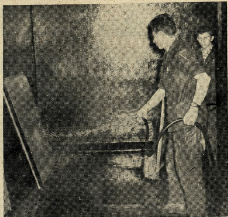
Delo v filmski tiskarni ni niti lahko niti enostavno, poleg tega je pa še »mokra«. Na sliki: čiščenje šablon z vodo
