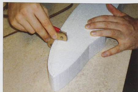
S pripomočkom za rezanje okroglih robov posnamemo na trupu vse robove, razen tam, kjer nanj nalegata krilo in višinski stabilizator.
