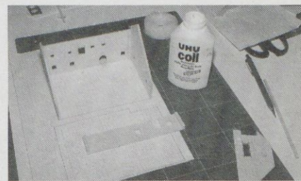
Vse štiri stene zlepimo s pomočjo letvic in postavimo na tloris, da je med njimi res pravi kot.
