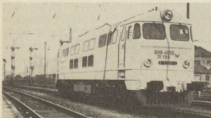
Najmočnejšo dizelsko lokomotivo z močjo skoraj 3000 kW je izdelala nemška tovarna Henschel za Kitajsko.
