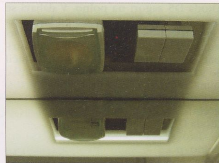
Način namestitve tipke Ti1 in svetleče diode D5. Z enakim drugim parom vključimo npr. sušenje brisač oziroma gretje stene, na katero je pritrjen nosilec z brisačami.
