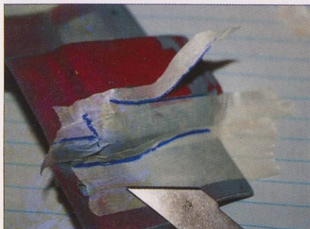
Slika 8. Izdelava šablone, ki jo bomo uporabili kot vzorec za rezanje samolepilne žametne tapete.
