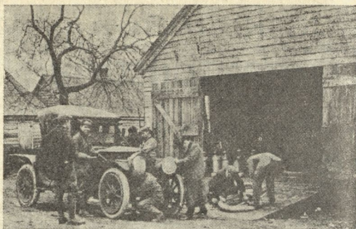
Slika 34 — Prva popravila so opravljali kar vaški kovači, kot tale na fotografiji iz prvih let našega stoletja. Posneta je bila nekje na podeželju v ZDA
