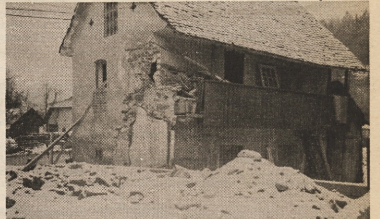
Ostanek hiše Franja Zagožna in temelji nove hiše. Voda je segala nad gornji rob spočnjega okenca.
