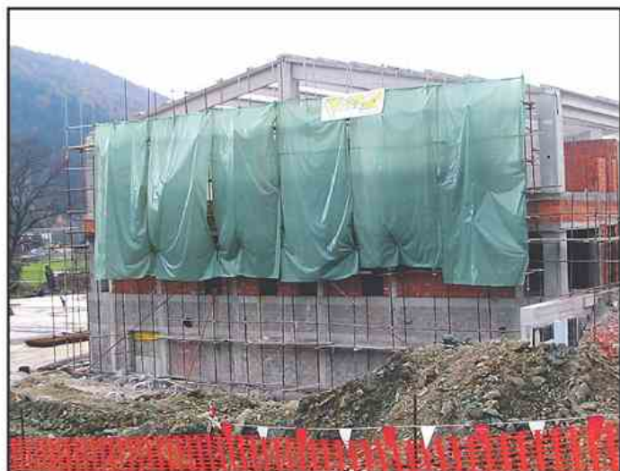
Velik objekt, ki raste tik ob občinski stavbi, gradi velenjski Veograd. V njem bo Tuševa trgovina, poslovni prostori in občinska prireditvena dvorana.
