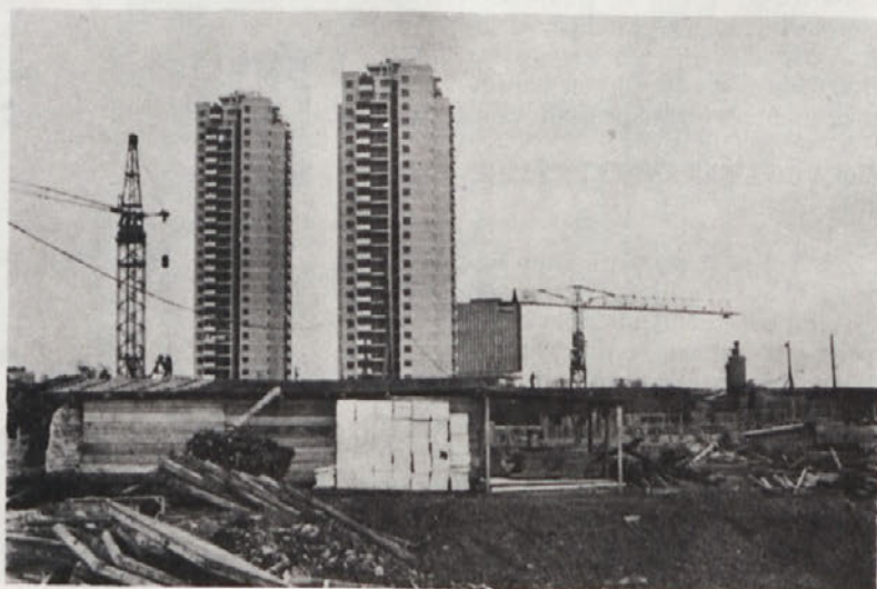
Gradbišče v Cvetnem naselju v Zagrebu je pripravljeno, v ozadju sta že zgrajeni stolpnici, dve prav takšni pa bomo še zgradili
