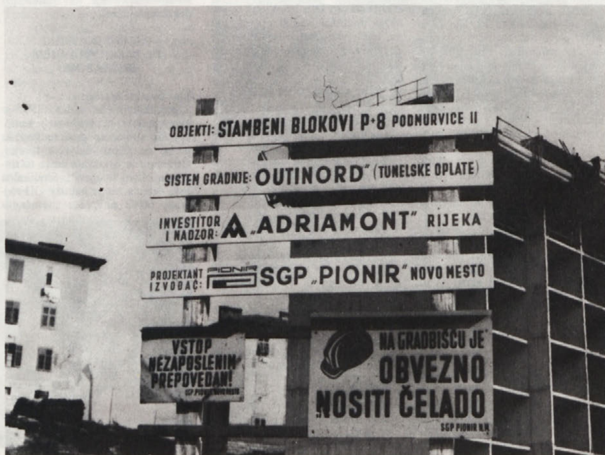
Napisna tabla z mnogimi napisi in opozorili ob vhodu na gradbišče v Podmurvicah na Reki, kjer gradi TOZD gradbeni sektor Novo mesto stanovanjske stolpnice, ponudi že na prvem koraku celo vrsto obvestil
