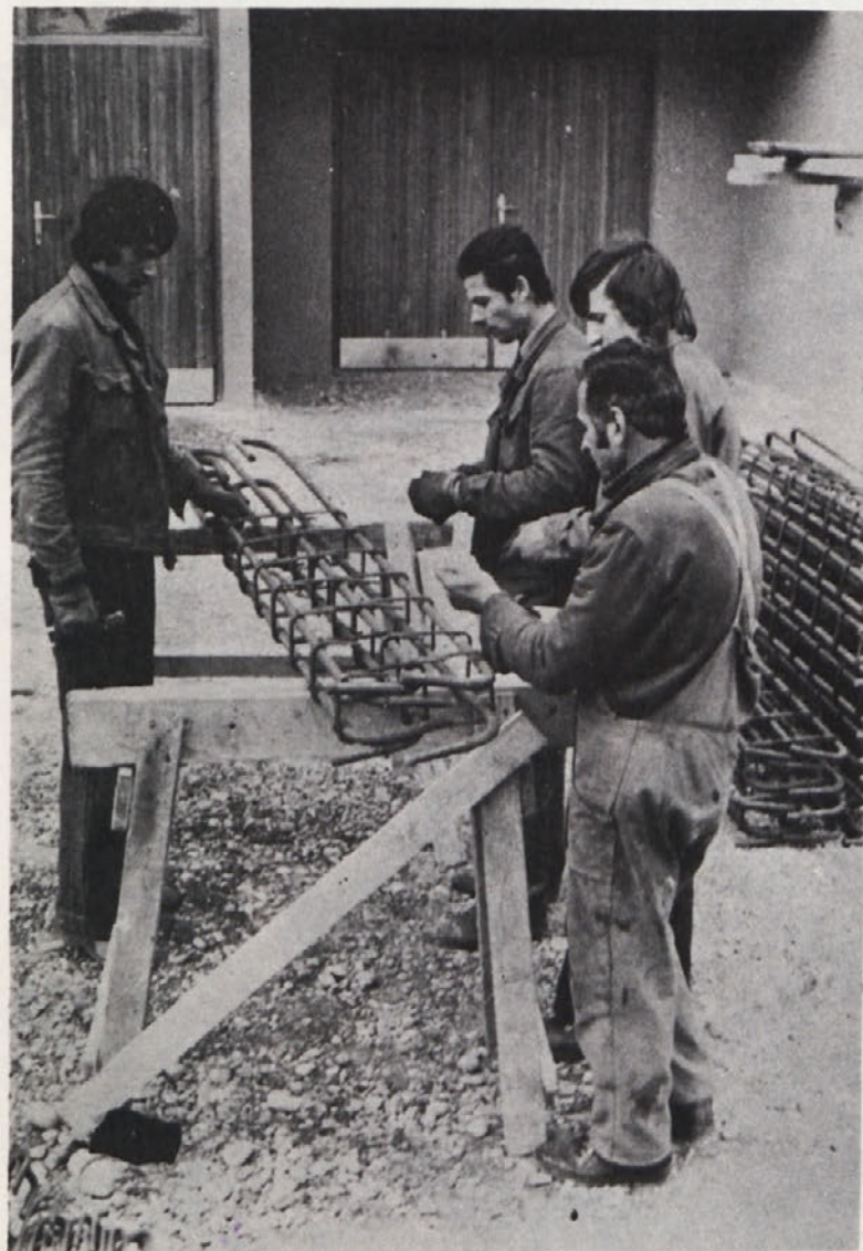
Skupina železokrivcev pripravlja betonsko armaturo za gradnjo trgovine v stanovanjski soseski na Ragovski v Novem mestu, ki jo gradi TOZD gradbeni sektor Novo mesto
