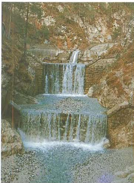
Slika 5. Sistem zaplavni pregrad v hudourniku Belca v Zgornjesavski dolini (foto Franci Rojnik, Vodnogospodarski inštitut, Ljubljana).
