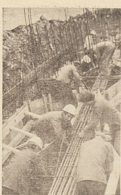
Da, hiteti je potrebno — Polaganje armature za oporni zid v Rušah
