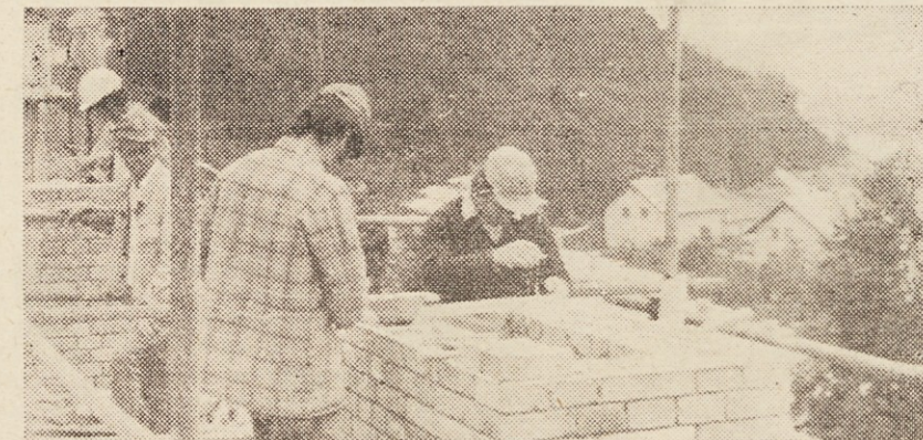
ZAKJUČNI IZPIT — Zidanje dimnika na samskem domu v Kranju
