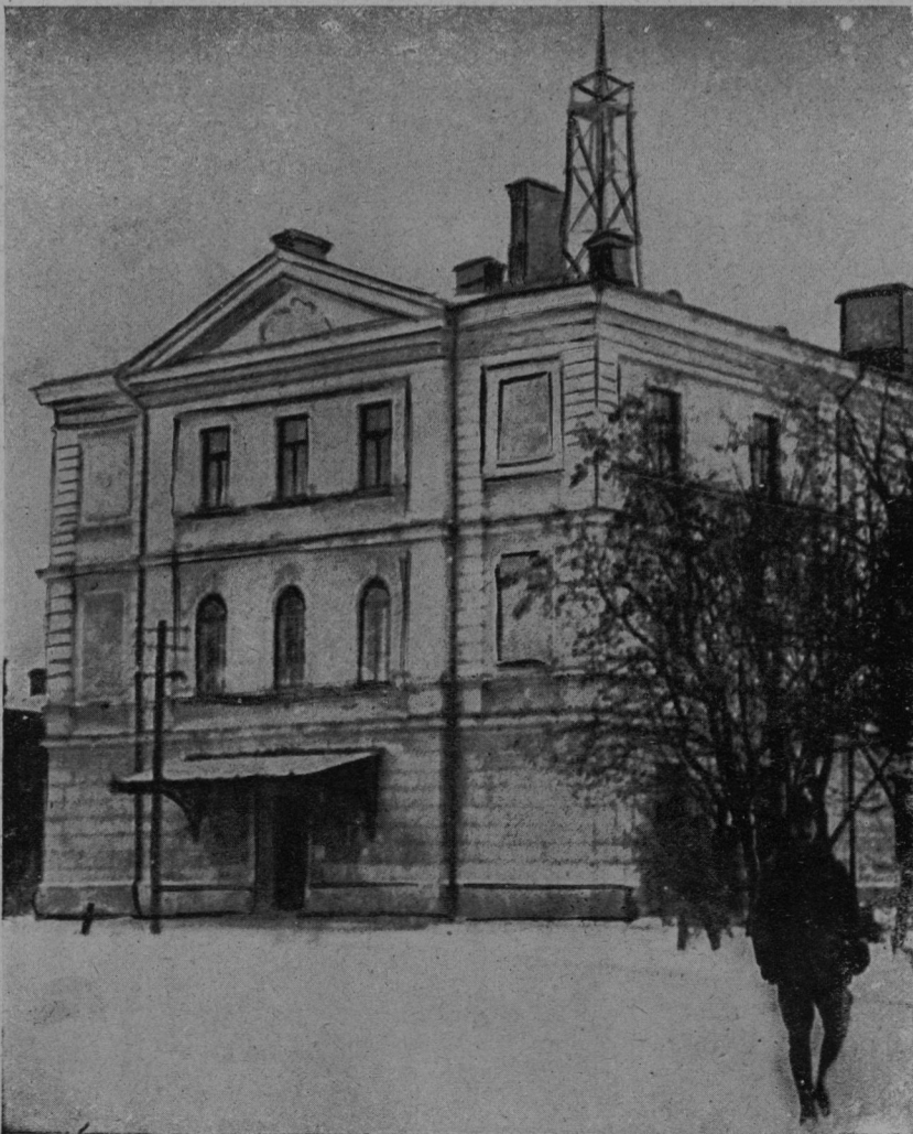
Iz Bresta Litovskega: Poslopje s 3 dvoranami za seje mirovnih pogajanj.
