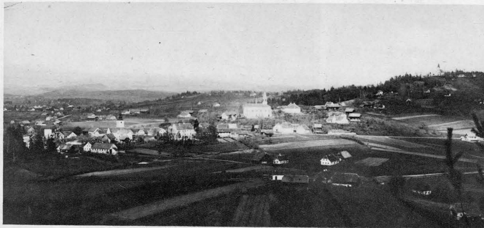
Pogled na Teharje pri Celju
