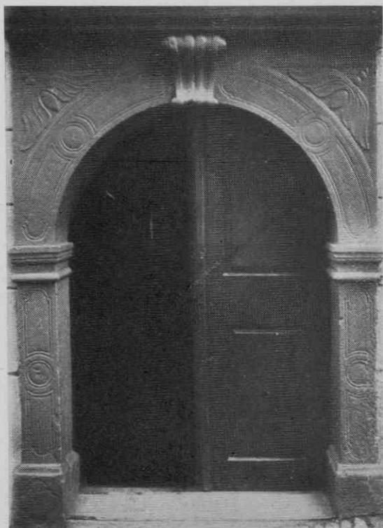
Slika 9. Portal Savski breg 7 (Foto MALj)
