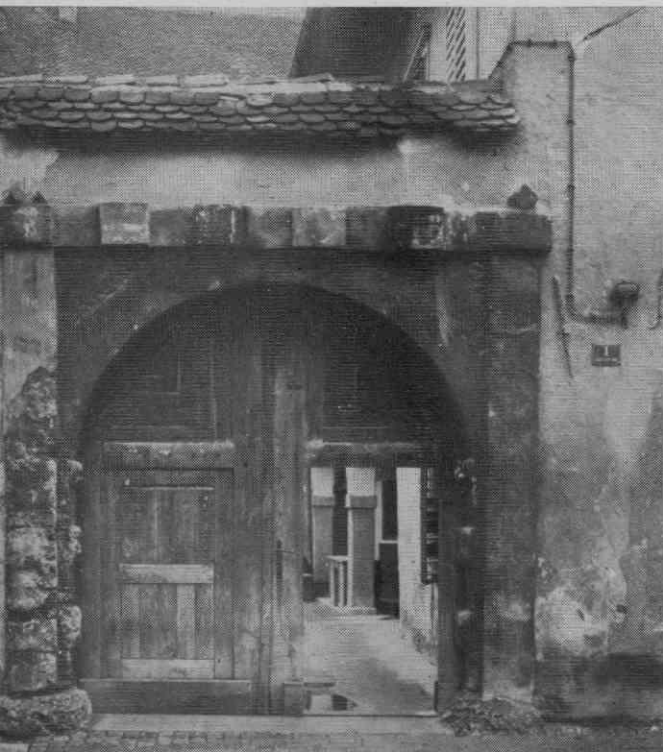
Slika 6. Grajski portal, na dvorišču (Foto MALj)
