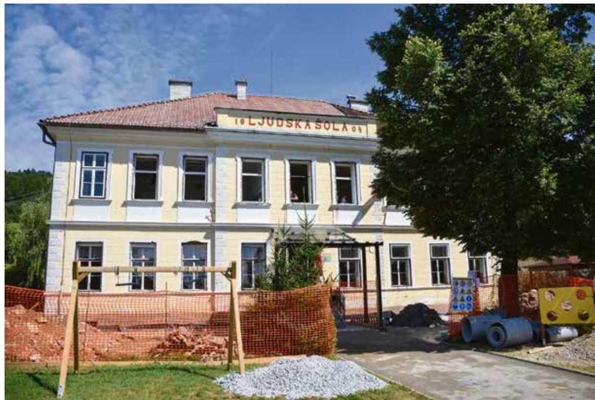
Sanacije šole v Stični je potekala tudi pod budnim očesom Zavoda za spomeniško varstvo
