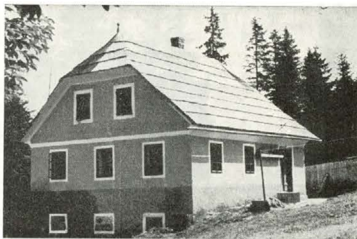
Naš delavec Martin Čopati je lepo popravil svoj dom v Javorju Foto Andrej Šertelj
