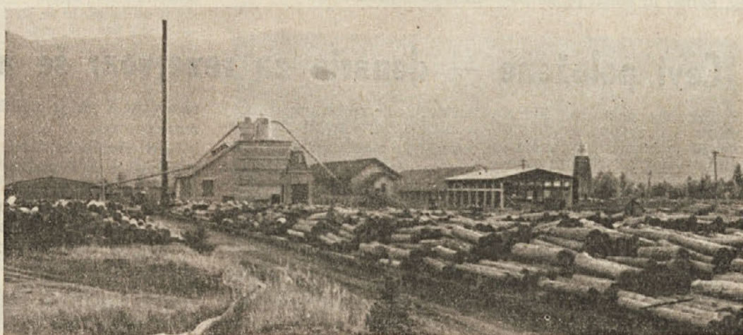
Na skladišču lesa lesne industrije v Kočevju
