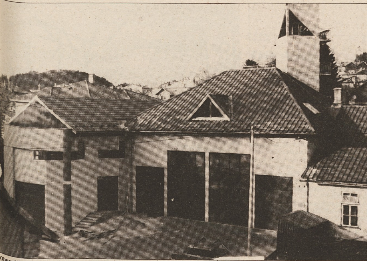
Obnovljeni gasilski dom v Postojni s prizidkom doma SLO.
