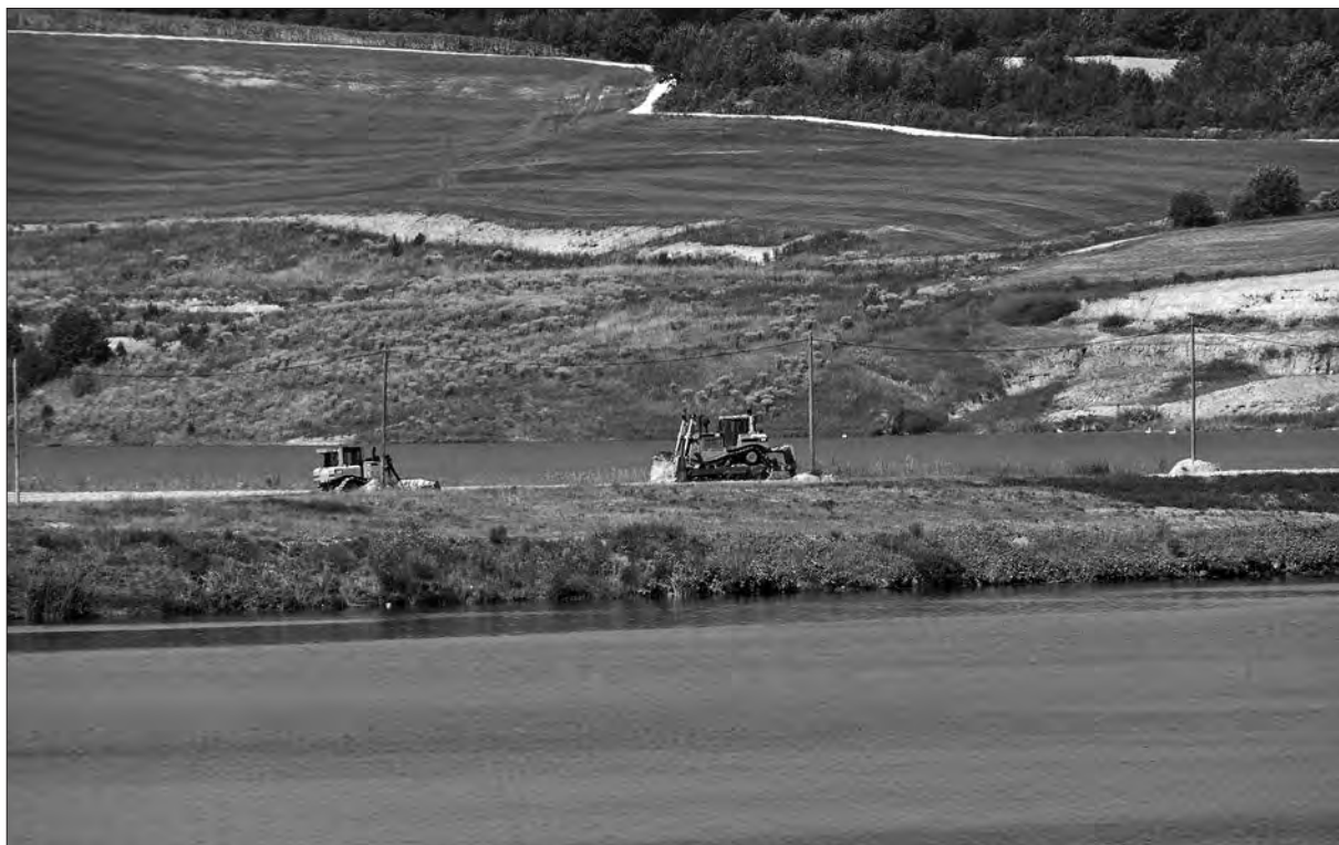
Slika 6: Nasip med Velenjskim (spredaj) in Družmirskim jezerom, katerega najmanjša širina je bila leta 2019 360 m. 33 Zadaj je vidno ugrezanje površja na zahodnem bregu Družmirskega jezera z lepo vidno stopnjo med ugreznjenim in neugreznjenim površjem (foto: Matija Zorn, 20. 8. 2021).
