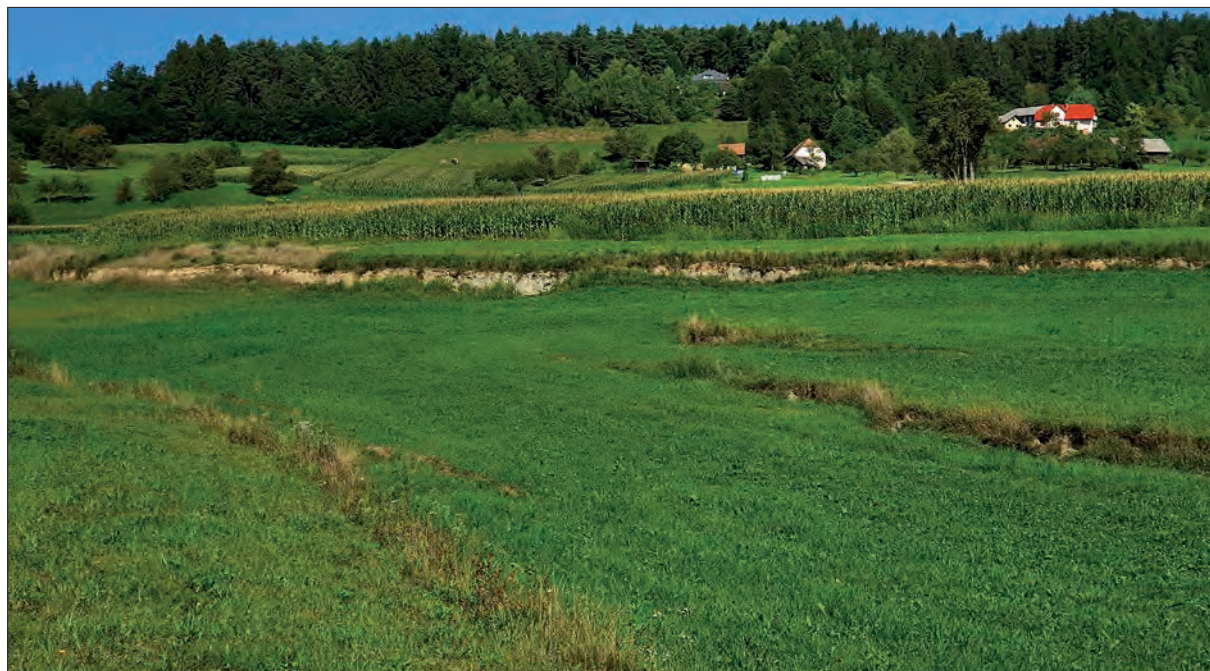
Slika 3: Ugrezanje površja severno od Družmirskega (Šoštanskega) jezera, na območju Žabje vasi (Gaberke). Na travniku so lepo vidne ugrezniske »ježe«. Povprečen naklon razpok na površju je 43^\circ , pod površjem pa je večji ( 60^\circ ) 26 (foto: Matija Zorn, 20. 8. 2021).
