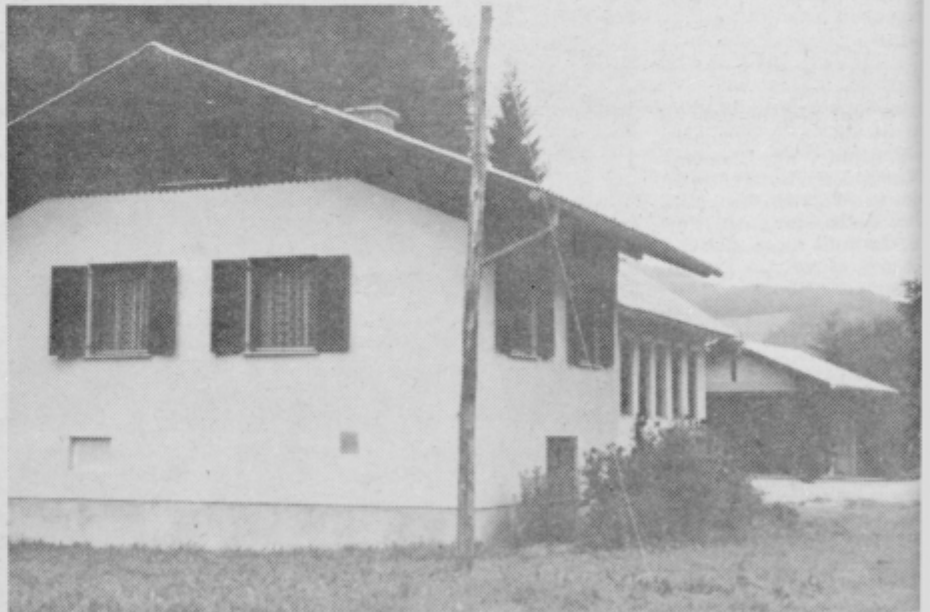
Obnovljeno in posodobljeno strelišče v Rečici pri Laškem.
