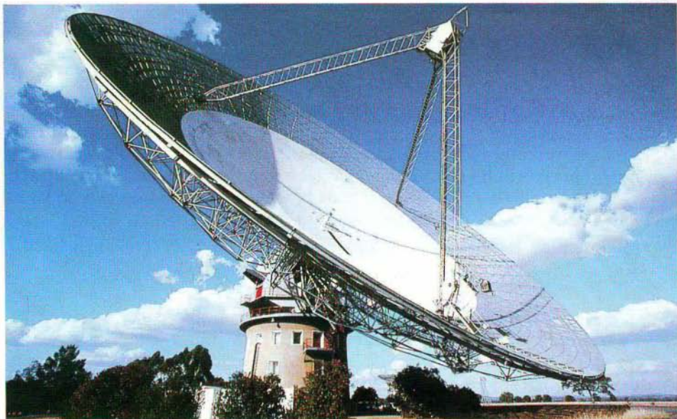
Slika 2. Antena avstralskega radijskega teleskopa Parkes, ki je nekaj mesecev v letu 1995 iskala signale zunajzemeljskih civilizacij. Antena ima premer 64 metrov in tehta 300 ton. Sprva je bila izdelana za opazovanja pri valovnih dolžinah 10, 21 in 75 centimetrov, kasneje pa so jo dopolnili tako, da deluje tudi pri krajših valovnih dolžinah.
