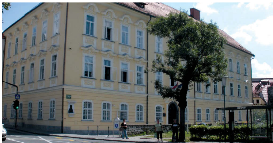
Stavba Arhiva Slovenije v Ljubljani.
