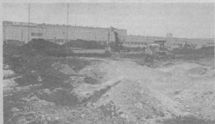
Na posnetku: pripravljala dela, odkrivanje trase in odvažanje materiala
