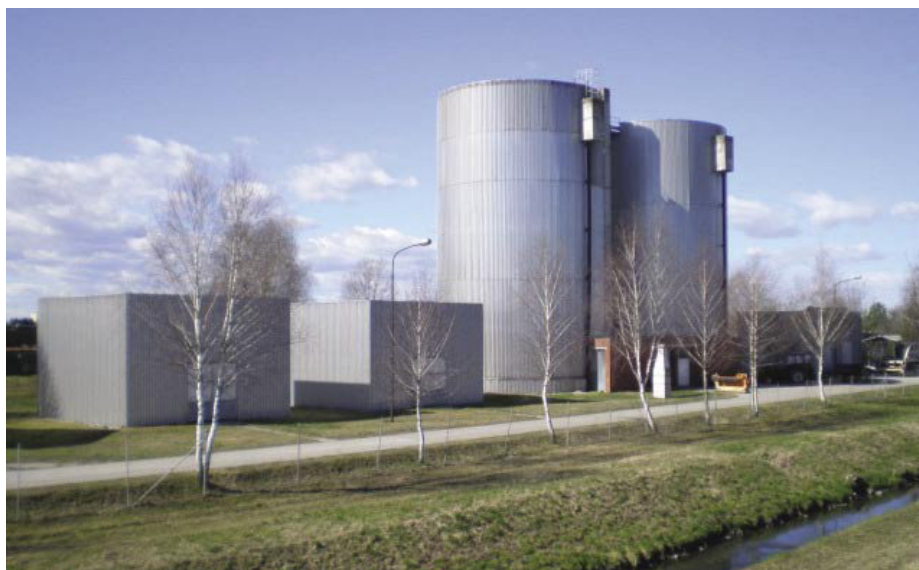
Slika 10 • Namesto male HE z močjo 2000 do 3000 kW v Markovcih so za 180 kW zgradili dražje primarne usedalnike in gnilišča, s porušljivo anoksičnega dela pa napravo osiromašili za denitrifikacijo
