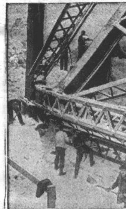
PODRTIJE NIAGARSKEGA MOSTU. Ameriški delavci odstranjujejo sloviti železni most pod Niagarskimi slapovi.
