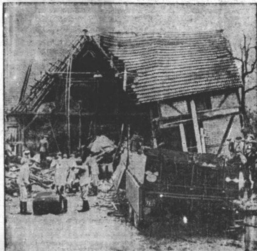
ČE SE AVTOMOBIL ZALETI. V Lohru am Mejn je neki avtomobil zaletel v hišo, da se je podrl. Na sliki vidimo podrtije stavbe po katastrofi.
