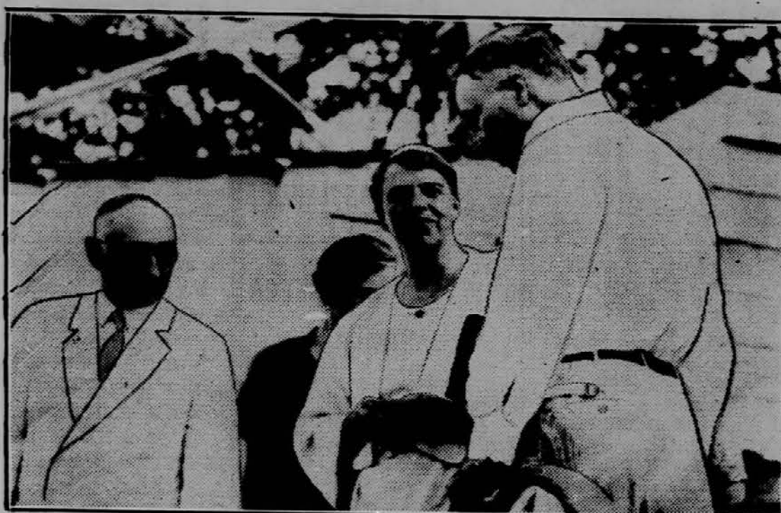
Žena predsednika Roosevelta si je pred kratkim ogledala velike vladne gradnje pri Knoxville, Tenn. Takoimenovani Norrisov nasip, ki ga grade, bo velike važnosti. Na desni je Ross White, ki načeljuje gradnji.
