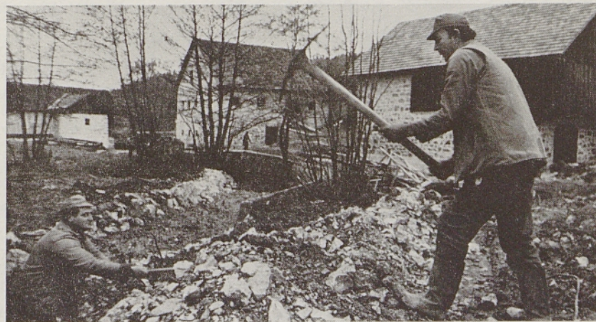
Obnova Trubarjevega mlina (na sredi) in žage (levo) z gospodarskim poslopjem v novembru 1985
