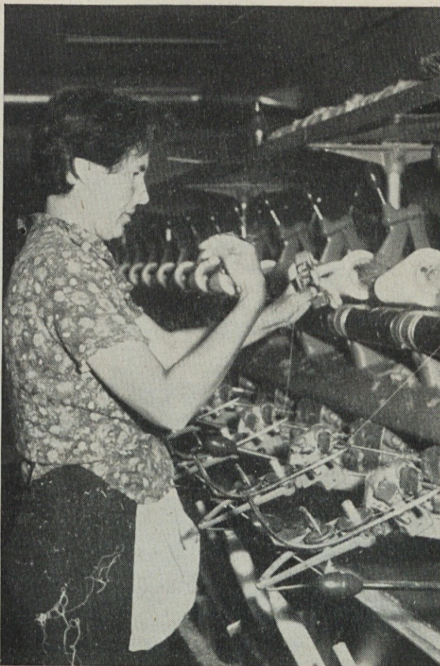
Na SAVIO previjalnih strojih se previje veliko sukane in enojne preje
