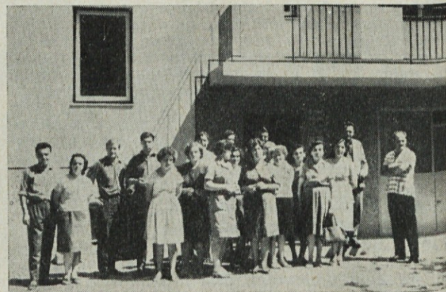
Bodoči sosede pred novozgrajeno polstolpnico ob prevzemu ključev
