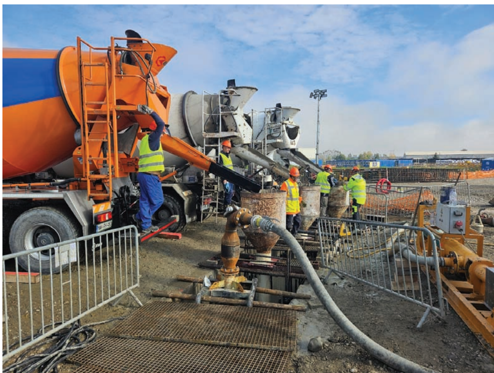
Slika 7. Kontraktorsko betoniranje primarnega panela.
