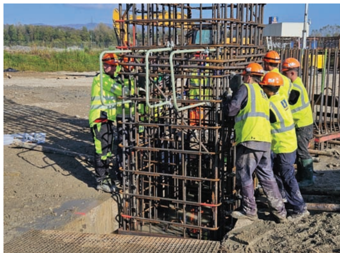
Slika 6. Stikovanje armaturnih košev.
