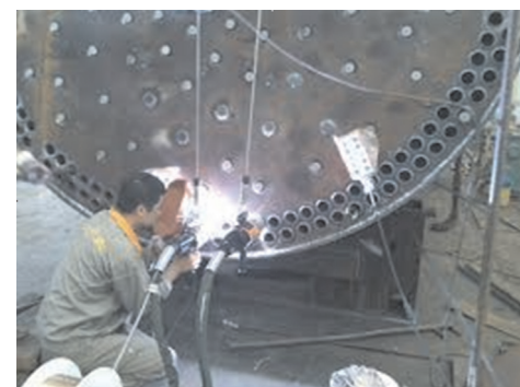
Varjenje parnega kotla
