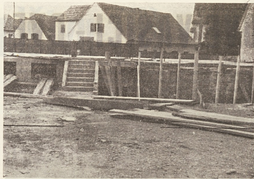
Na starih temeljih bomo zgradili novo upravno poslopje
