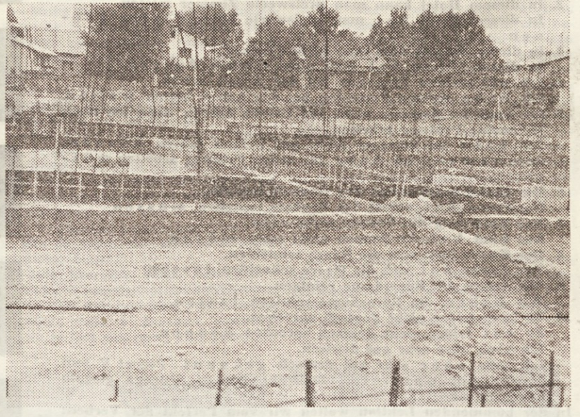
Temelji osnovne šole so postavljeni
