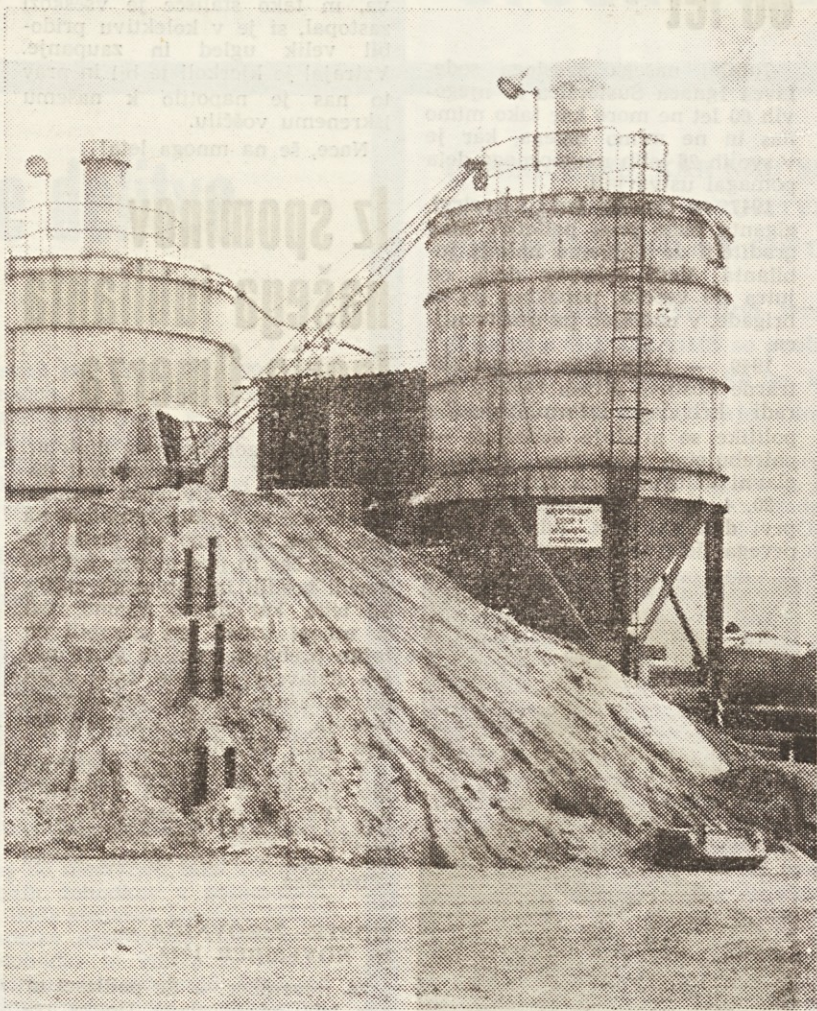
To pa je naša stara betonarna
