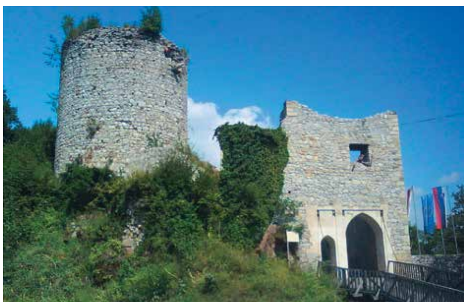
Slika 14: Pogled na delno obnovljen gotski vhod, ločen za pešce in vprego, ter osrednji obrambni stolp še v prvotnem stanju avgusta 2009.
