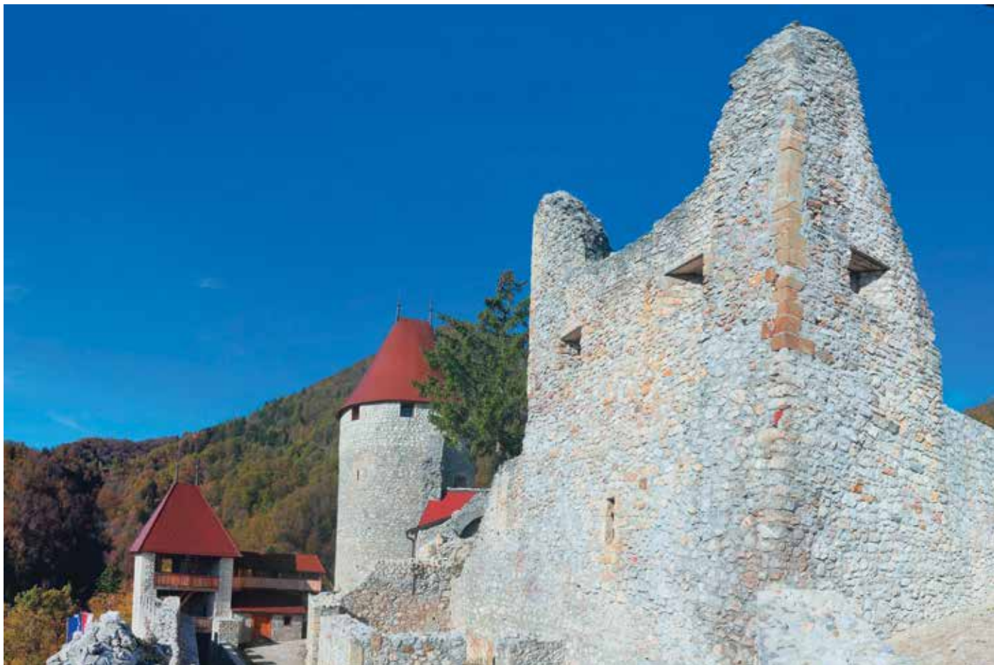
Slika 17: Jugovzhodni vogal palacija (pogled z vzhoda) Na vseh upodobitvah in fotografijah iz 19. in 20. stol. je ta del ruševin poleg obrambnega stolpa najbolj viden.
