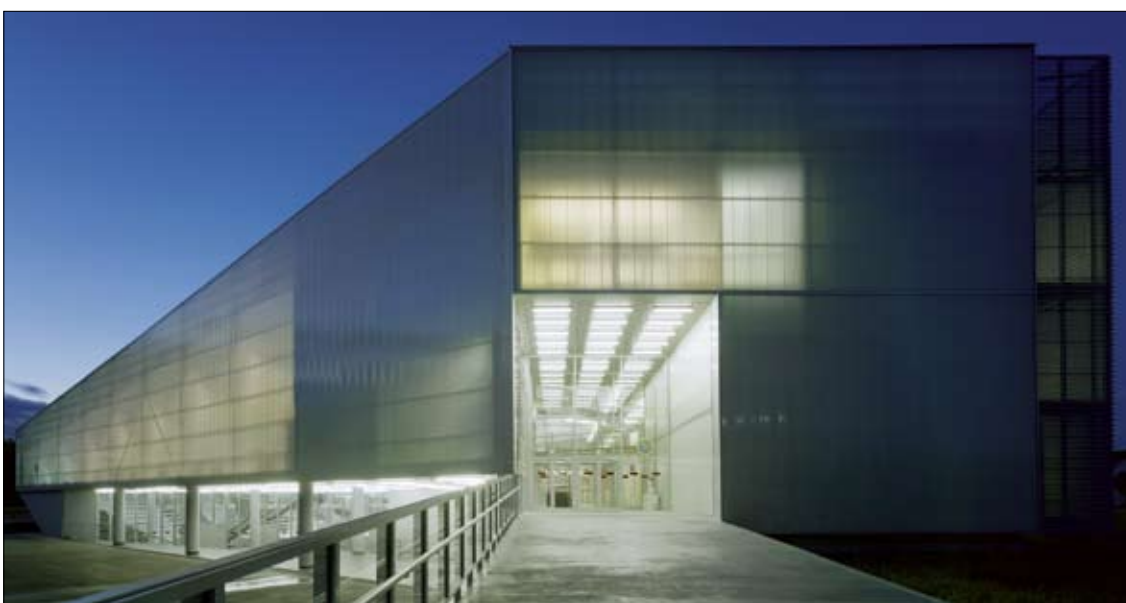
Gimnazija 46° 09' N / 16° 50' E, Koprivnica; projekt: Lea Pelivan in Toma Plejič, Studio UP; Foto: Robert Les
