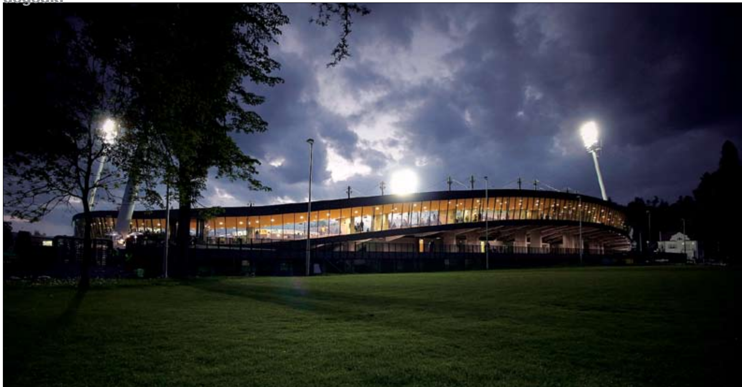
Razširitev stadiona Ljudski vrt, Maribor; projekt: Ales Žnidaršič in Katja Žlajpah, multiPlan arhitekti ter Rok Oman in Špela Videčnik, OFIS Arhitekti; foto: Tomaž Gregorič
