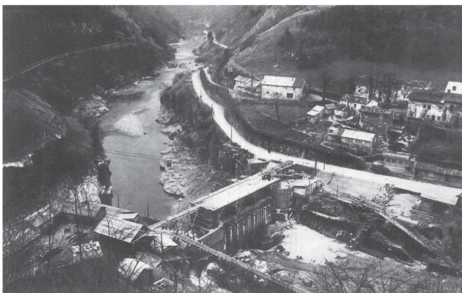
Gradbišče jezu Podselo.
