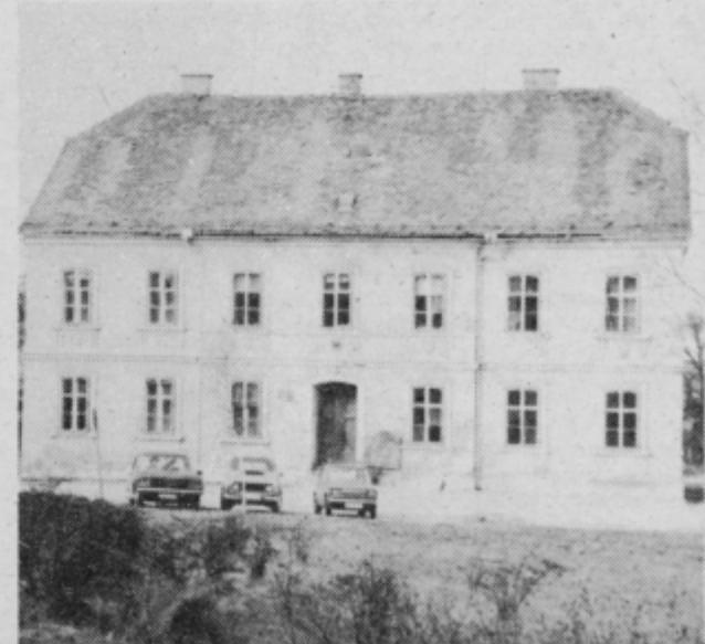
Samo majhen razred prvošolčkov s svojo tovarišico in pa vrtec gostujeta v tej zanemarjeni šolski stavbi. Predvsem fasada na pročelju ni za okras
