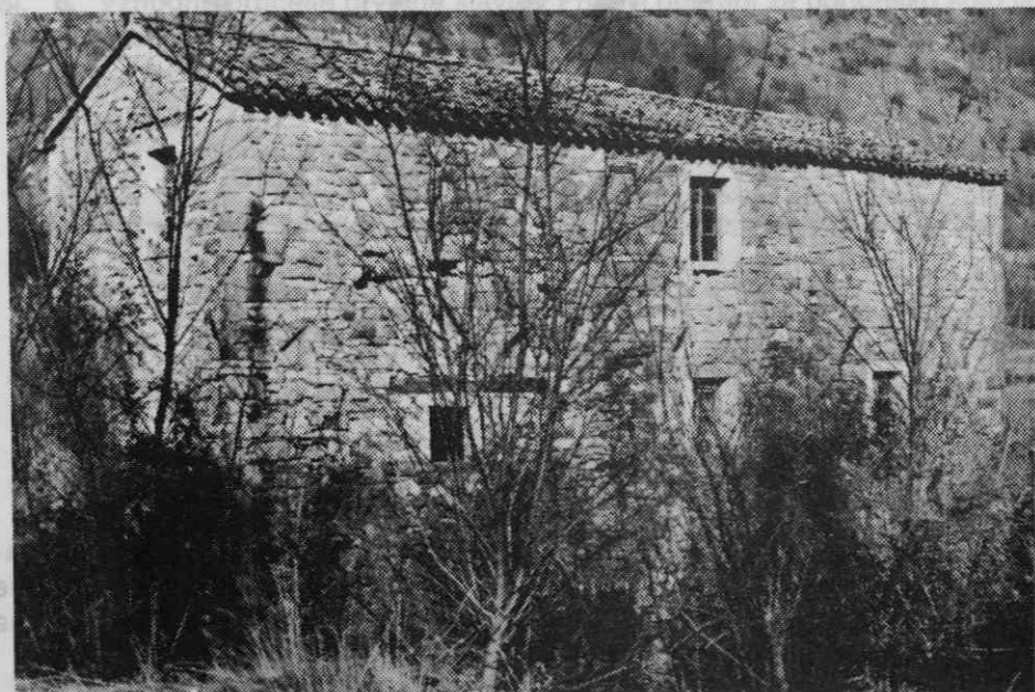
Sl. 9. Pogled na južno in vzhodno pročelje sedanje stavbe
