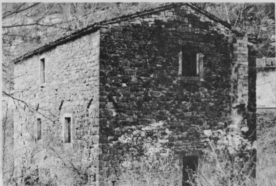
Sl. 8. Pogled na vzhodno in severno pročelje sedanje stavbe
