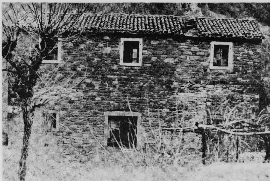
Sl. 10. Zahodno pročelje sedanje stavbe
