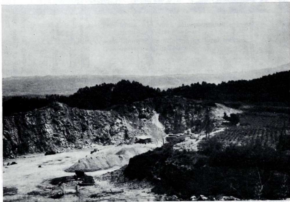
Sl. 1. Pogled na površinski kop »Slane Stine« (slikano sa jugozapada)
