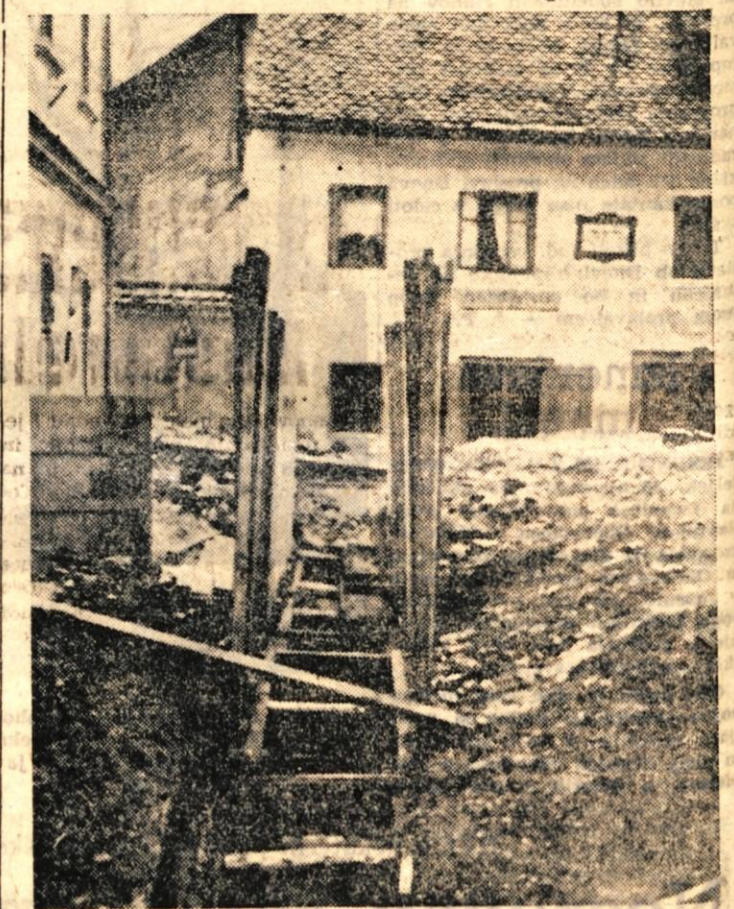
V Škofji Loki so pričeli kopati novo kanalizacijo v samem mestu. Sedanja kanalizacija je bila namreč stara več kakor 300 let, zato njene zmogljivosti niso več ustrezale (Foto: V. Rozman)
