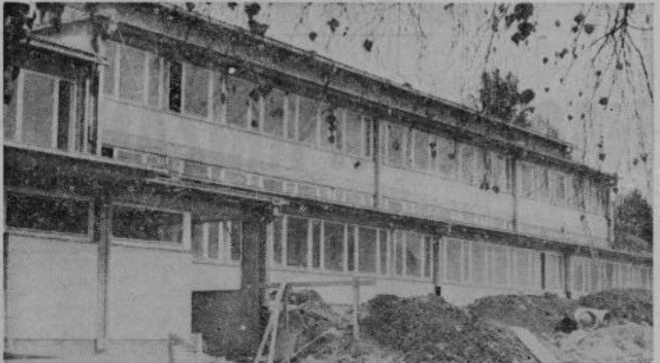
Gradbena in obrtniška dela na novi šoli v Podčetrtku dobro napredujejo in ni več daleč čas, ko se bodo otroci, ki so se do sedaj stiskali v utesjenih in neustreznih prostorih stare šole, preselili v nove, svetle in zračne učilnice. Dani pa bodo tudi pogoji za sodoben kabinetni pouk in za različne izvenšolske dejavnosti, ki jih v osnovni šoli v Podčetrtku ne manjka.
