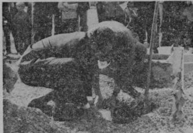
Vgrajen je temelj za telovadnico v Zrečah.
